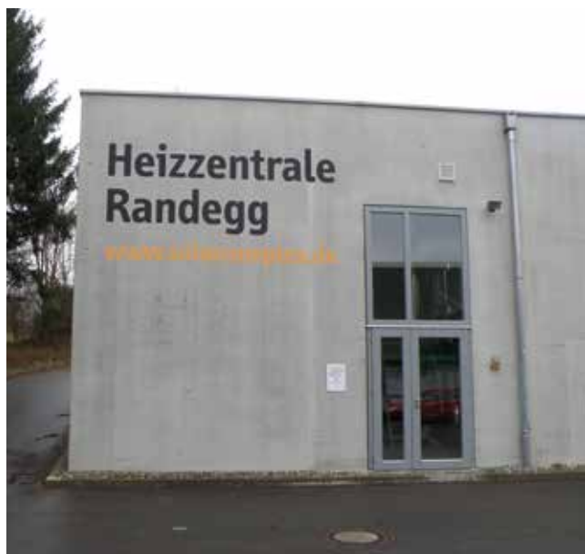
Die Pellet - Zentrale, Herz der Energieversorgung
